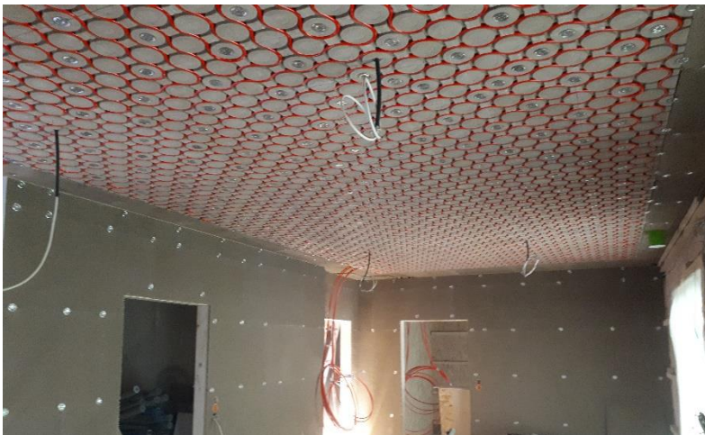
Vollflächige Deckenbelegung mit HochLeistungsLehm-Modulen und Lehm-Neutralplatten
