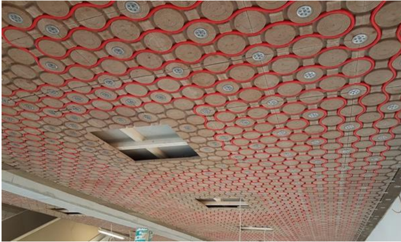
Befestigung an Unterbauschalung mit diversen Deckenauslässen
