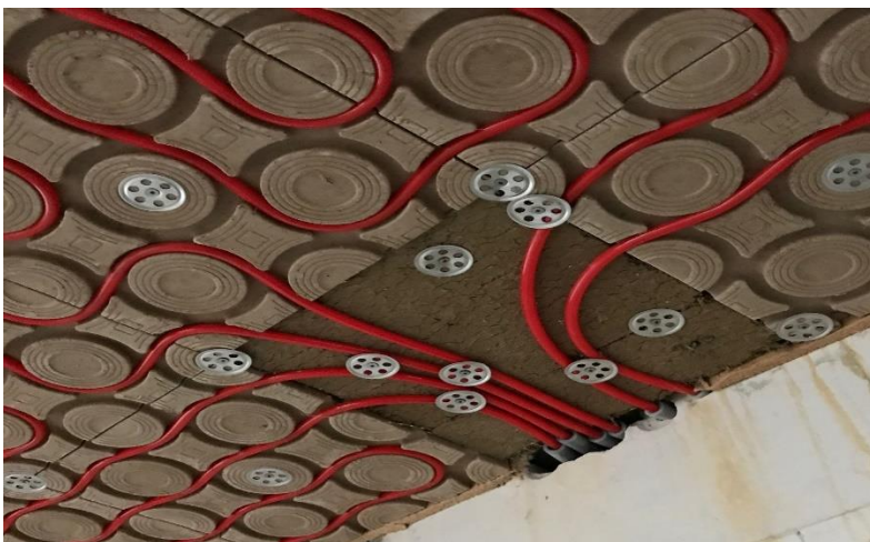
Anschlussfläche mit 13mm Lehm-Anschlussplatte als Putzträger
